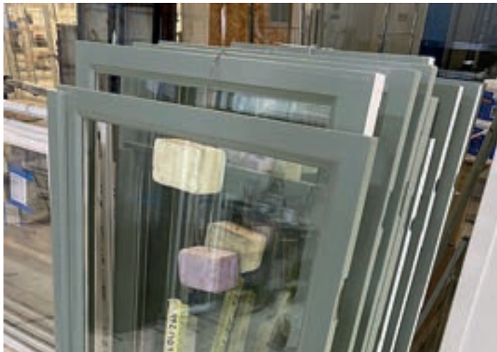
Färdigrenoverade och målade ytterbågar med nytt energiglas insatt.
