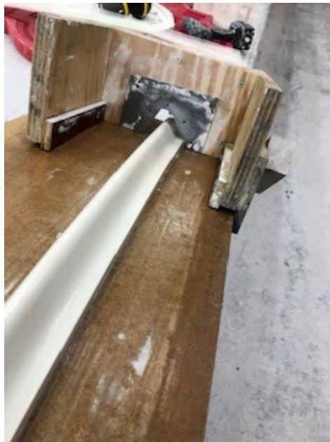
Till vänster: En stucklist dras fram. Till höger: En färdig stucklist ligger och väntar på träbågen. Foto: Daniel Hillman.
