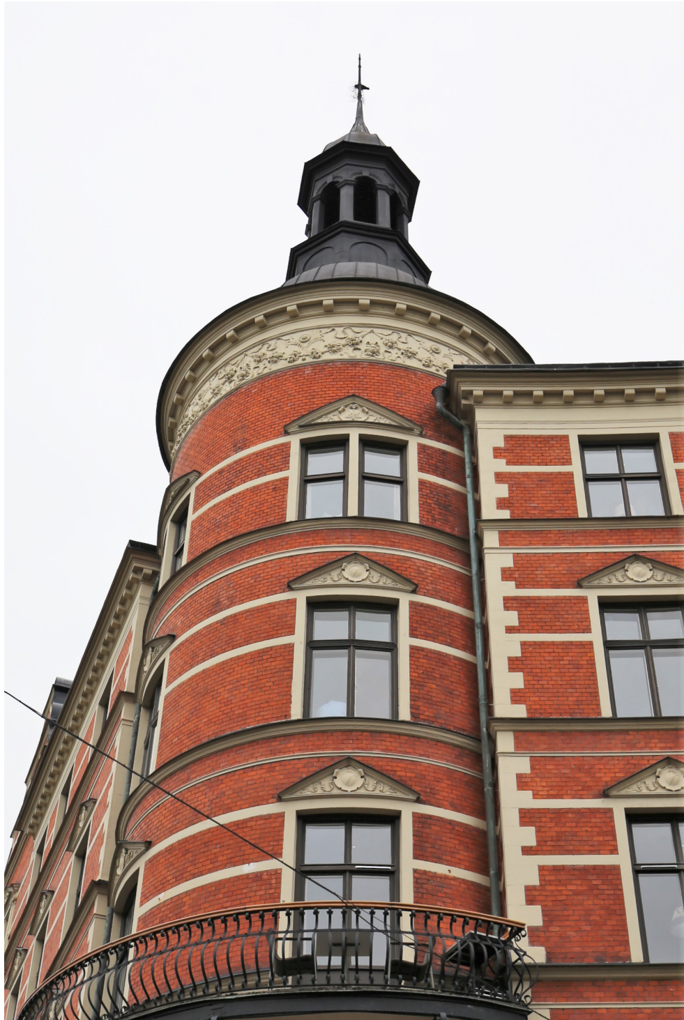
Närbild på byggnadens hörntorn i augusti 2018, det vill säga två år innan upprustningsprojektet av tornets plåttak och stuckfris genomfördes.
