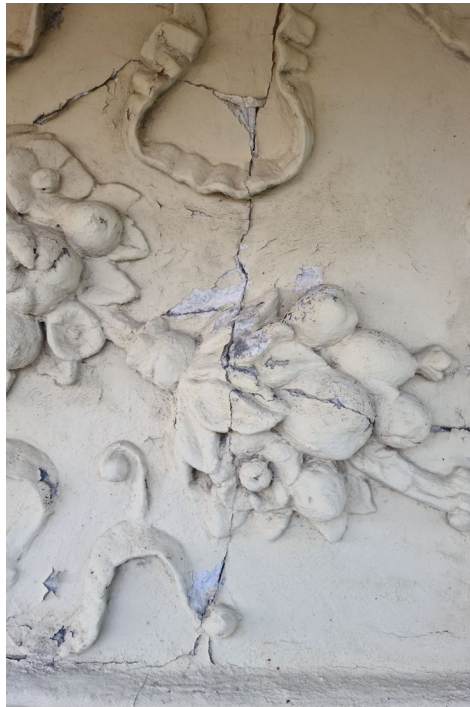
Närbilder på den ursprungliga stuckfrisen, där det uppstått sprickor i själva frisen.
