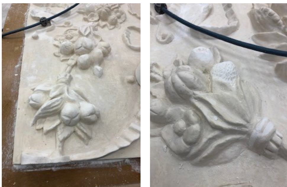
Rekonstruktion av bortfallna ornament på stuckfrisen pågår. Foto: Daniel Hillman.
