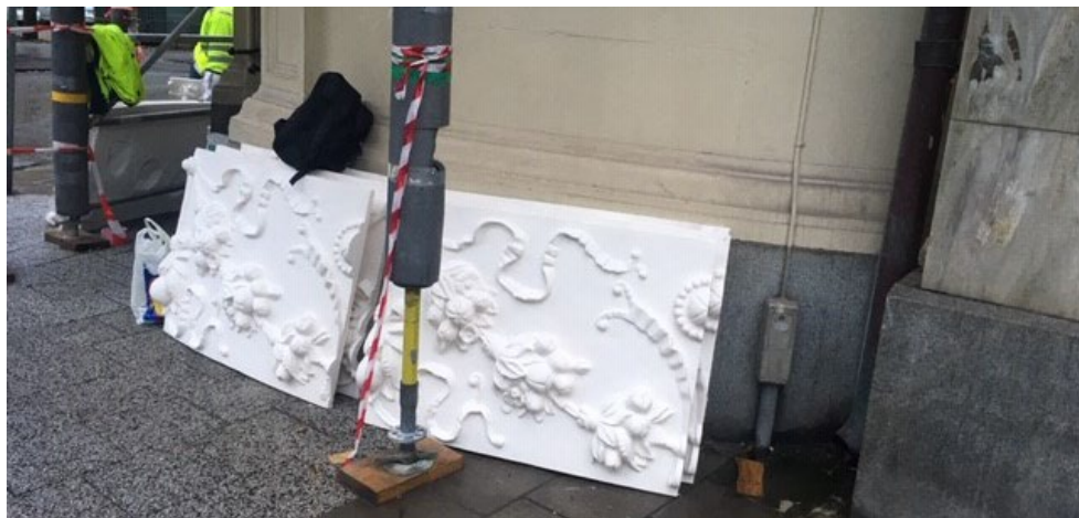
Den nytillverkade stuckfrisen, i väntan på att lyftas upp på Karlaplan. Foto: Karl-Magnus Westrin.
