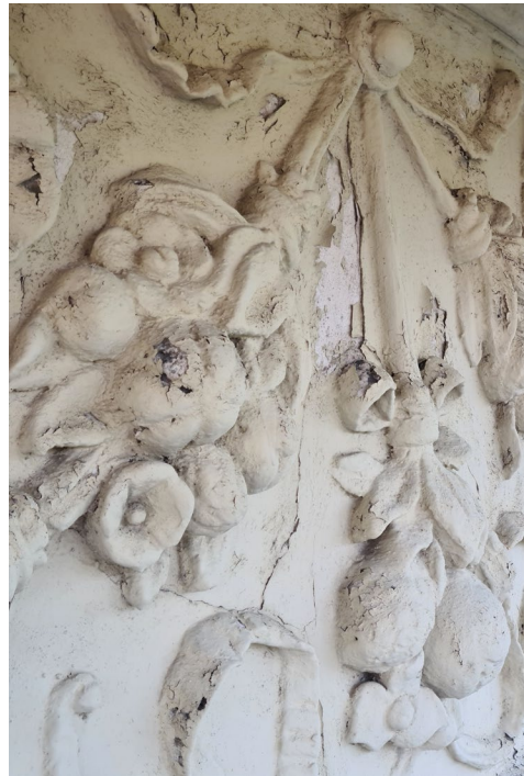
Närbilder på den ursprungliga stuckfrisen, där det uppstått sprickor i själva frisen.
