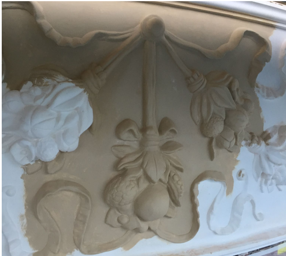
Impregneringsarbetet pågår. Foto: Bjöm Forsman.
