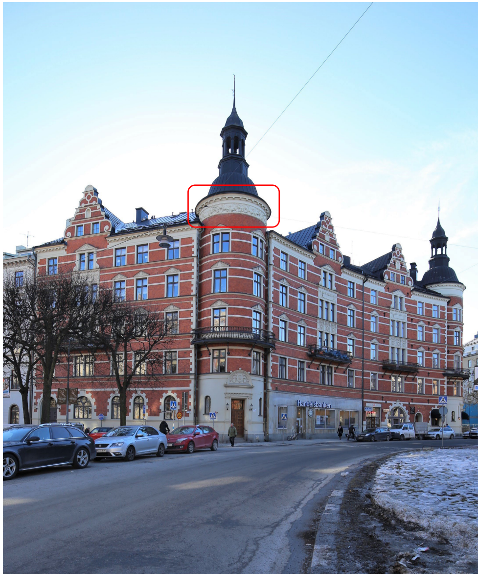
Flerbostadshusen på fastigheterna Harpan 24 och 25, mot Narvavägen och Kartaplan i mars 2018. Den aktuella frisen är inringad med rött. På grannhuset (Harpan 25) är stuckfrisen på motsvarande plats borttagen sedan lång tid tillbaka.
